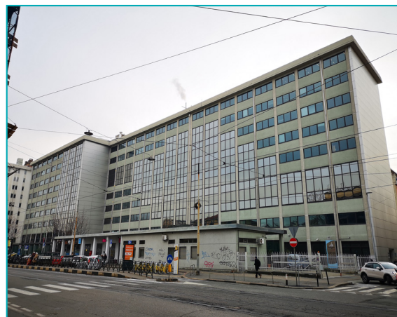
L'edificio che ospita gli uffici della polizia Municipale di Torino. Opera di efficientamento energetico attualmente in corso.
